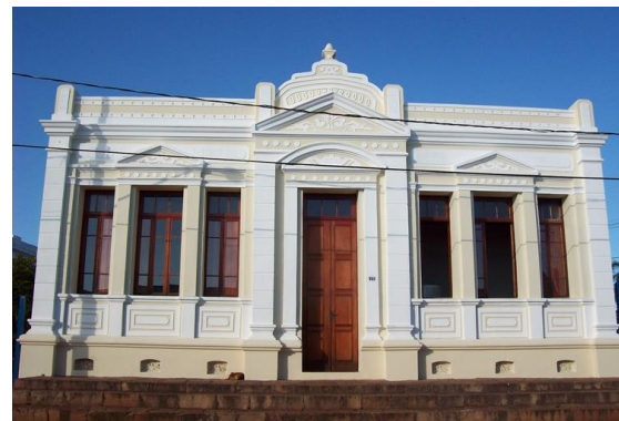
76. MUNICIPIO DE SACRAMENTO – PRAÇA CÔNEGO HERMOGENES, 75 – (TOMBADO) - PREFEITURA MUNICIPAL DA SACRAMENTO. FOTO: VIRGINIA DOLABELA 2005.
