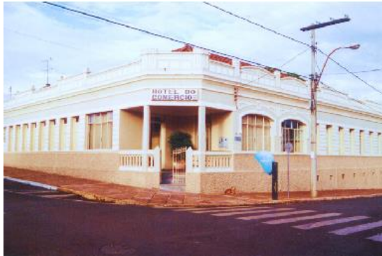
55. MUNICIPIO DE SACRAMENTO – RUA MAJOR, 123 – ESPÓLIO DE ÍTALO CERCHI. FOTO: VIRGINIA DOLABELA 2005.
