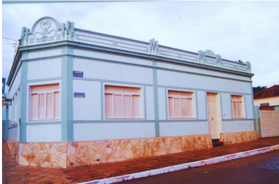
72. MUNICIPIO DE SACRAMENTO – AVENIDA CAPITÃO BORGES, 105 – JAMIL LEME. FOTO: VIRGINIA DOLABELA 2005
